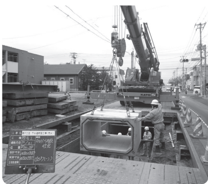
雨水管の整備
