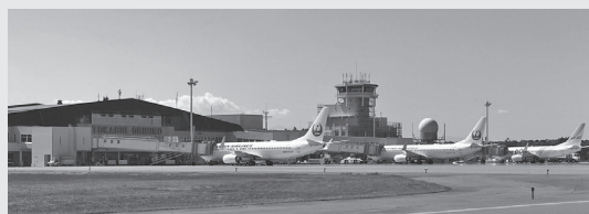
空港駐機場（エプロン）の拡張工事
