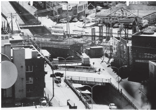
平成6年のアンダーパスと建設中の鉄道高架
