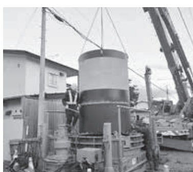
雨水管の整備
