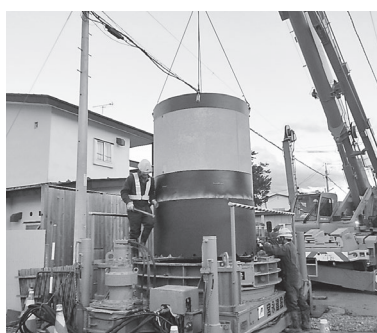
雨水管の整備
