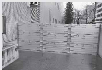
庁舎に設置した止水板
