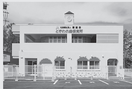
改築したときわの森保育所
