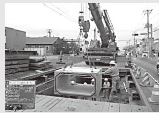
雨水管の整備
