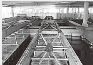
稲田浄水場 沈殿池設備
