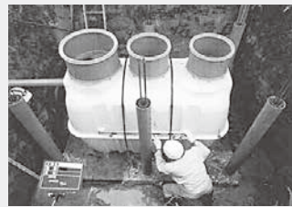
合併処理浄化槽の設置
