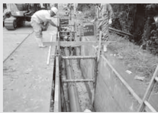
配水管の整備
