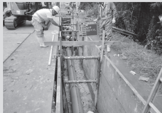
配水管の整備
