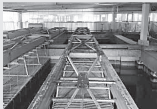
稲田浄水場 沈殿池設備
