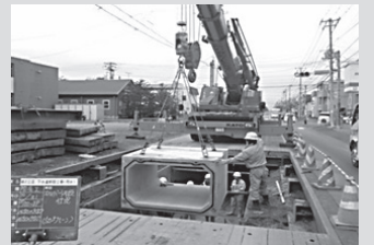
雨水管の整備
