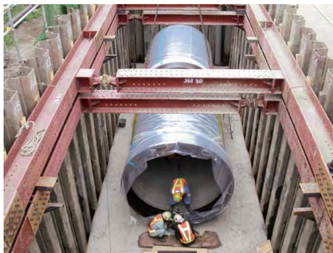
（緊急貯水槽の設置）
