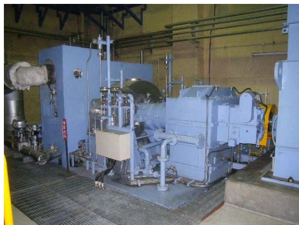
くりりんセンターの発電機
