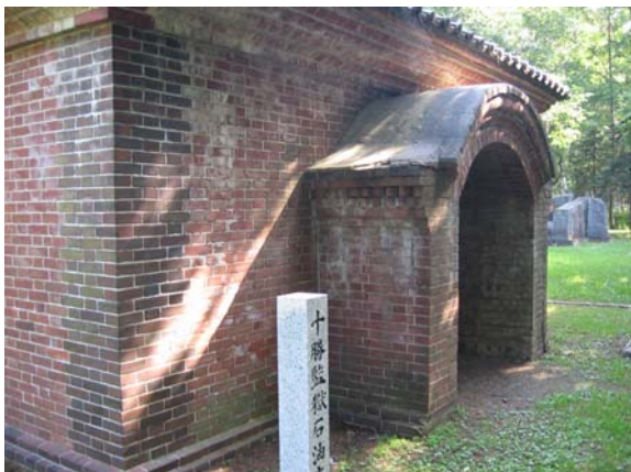
十勝監獄石油庫
