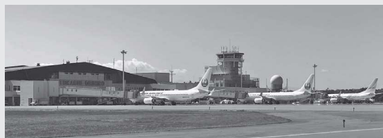
空港駐機場（エプロン）の拡張工事
