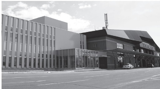
とかち帯広空港の新旅客ターミナルビルが完成
