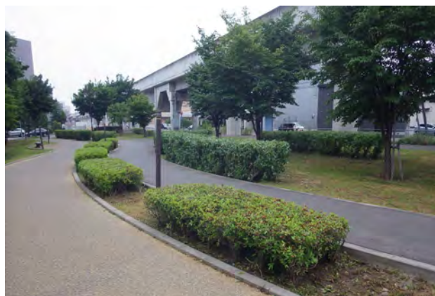
自転車歩行者道が整備されている 北栄グリーンロードの様子 ▶
