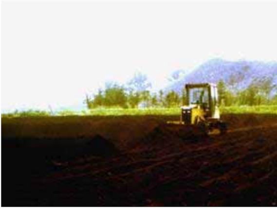
石礫を取り除き、ふるった土をブルドーザーで整地
