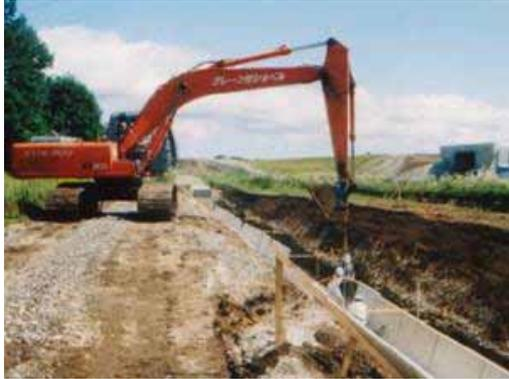
降雨時で水路が壊れないように、コンクリートの水路を敷設します。
