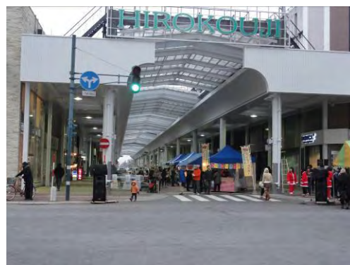
改修後の広小路アーケード
