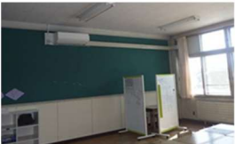
エアコン設置の様子
