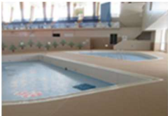
プールサイド床面の工事
