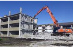
大空小学校 解体写真
