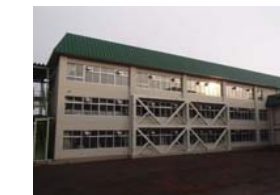
耐震化工事の実施 (第四中学校)
