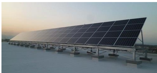
公共施設への太陽光パネルの設置
