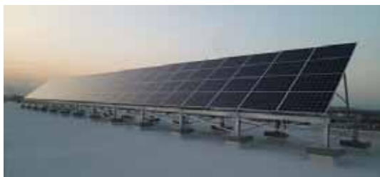
公共施設への太陽光パネルの設置
