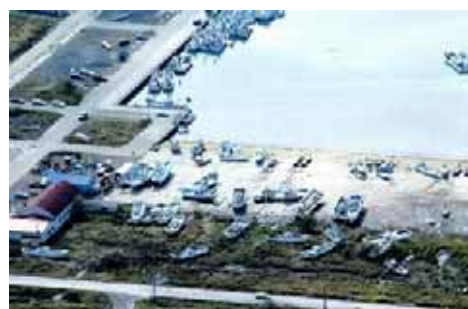
平成 15 年十勝沖地震（豊頃町）
