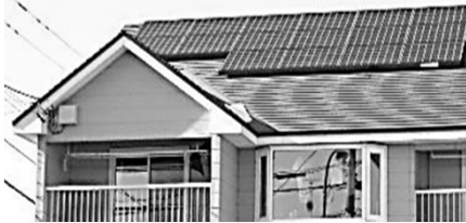
屋根に設置された太陽光パネル
