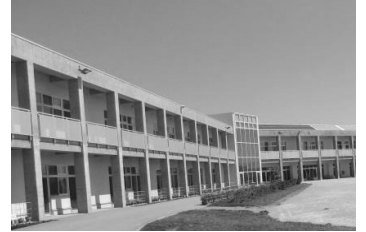
改築した校舎（豊成小学校）
