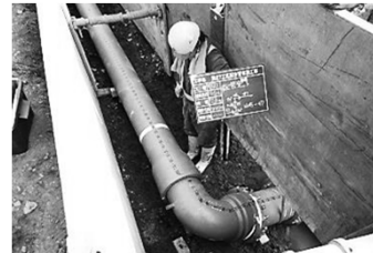
老朽化した配水管の更新の様子
