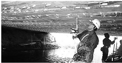
橋りょうの補修の様子
