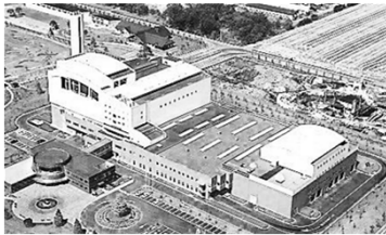
一般廃棄物中間処理施設（くりりんセンター）
