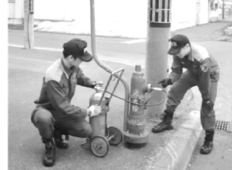
消火栓を点検している様子
