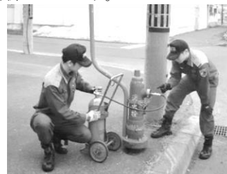
消火栓を点検している様子
