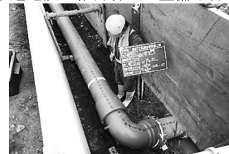
老朽化した配水管の更新の様子
