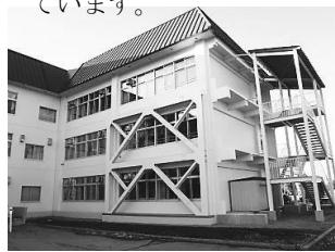
耐震化後の校舎（明星小学校）
