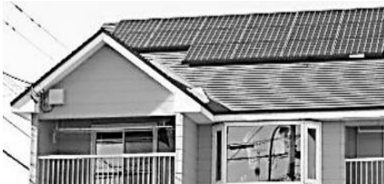
屋根に設置された太陽光パネル
