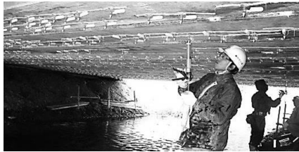
橋りょうの補修の様子
