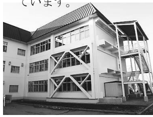
耐震化後の校舎（明星小学校）
