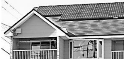
屋根に設置された太陽光パネル
