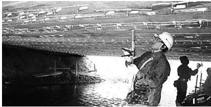
橋りょうの補修の様子
