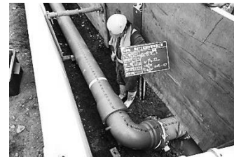
老朽化した配水管の更新の様子
