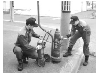
消火栓を点検している様子
