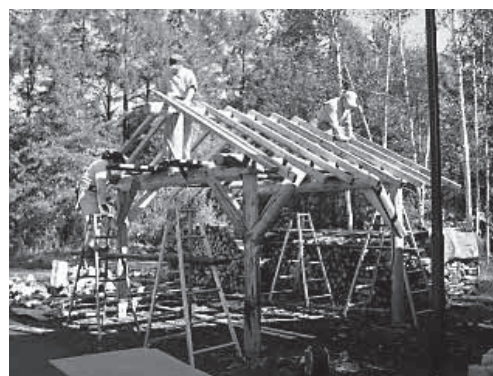
薪小屋づくり
