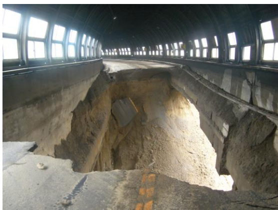
国道274号線 日勝峠9号目付近の 三国の沢覆道(日高町)
