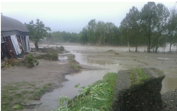
札内川と戸蔦別川の合流地点での堤防破堤 (帯広市中島町)
