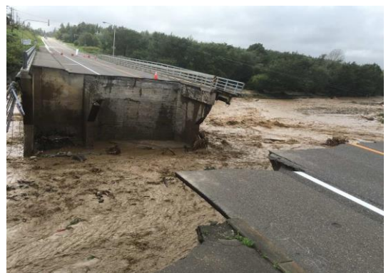
国道38号線 清見橋の崩落(清水町)
