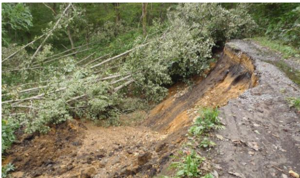
倒木、林道の損壊 村元の沢線（岩内町）
