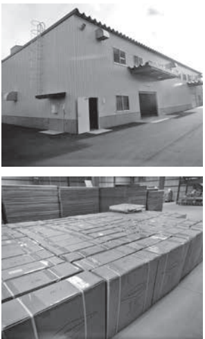
【拠点備蓄倉庫】
