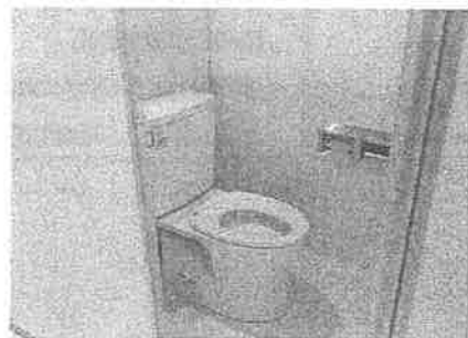
洋式化修繕を実施した北栄小トイレ
