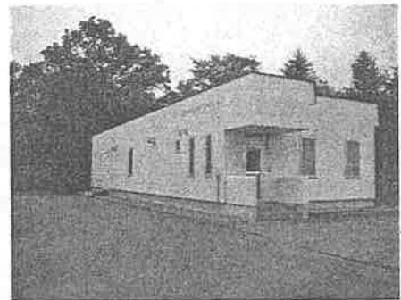
清川下水処理場
