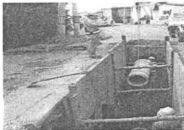
雨水管の整備
