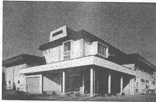
十勝川流域下水道浄化センター
