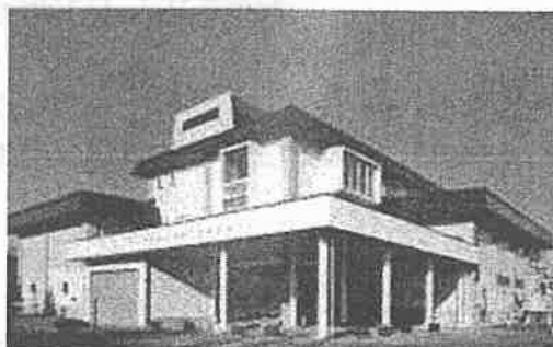
十勝川流域下水道浄化センター
