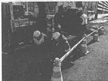
下水道管渠の長寿命化
