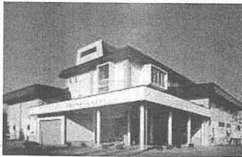
十勝川流域下水道浄化センター
