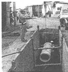
雨水管の整備
