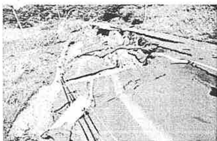
平成 15 年十勝沖地震（豊頃町）
